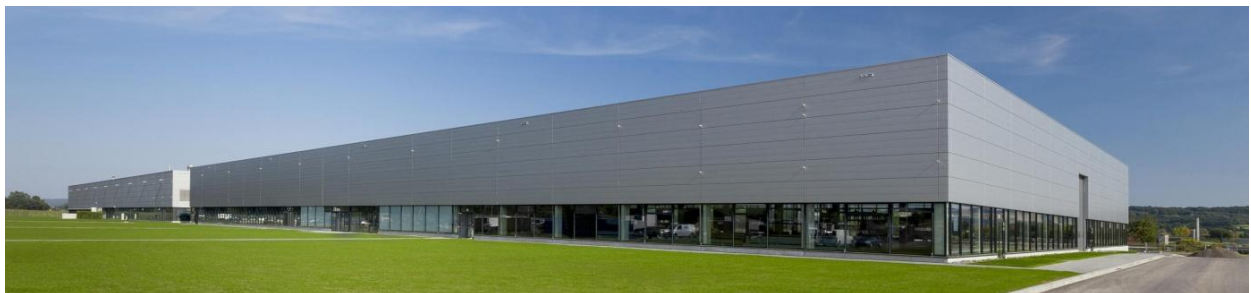
Produktionshalle von Seidel und Carus in Fronhausen bei Marburg. Unter dem Dach dieser Werkshallen produziert Carus seit 2014 Leuchtmittel mit LED-Technik
